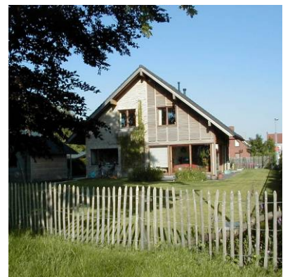
Afbeelding 1 : Voorbeeld van een lage-energiewoning in houtskeletbouw (KRONOS-architectuur, Ruddervoorde, 2000)
