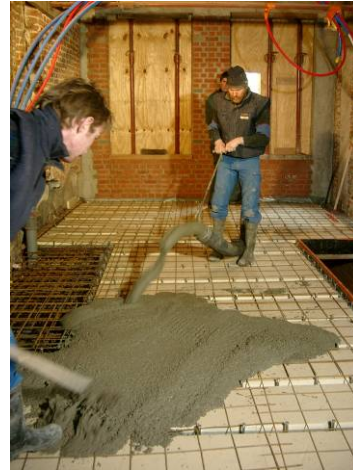
Afbeelding 2 : Realisatie van een anhydriet-gietvloer in een woning in houtskeletbouw (links) [foto WTCB, Ukkel, 2003]; realisatie van een hout-betonvloer in het kader van de renovatie van een historisch gebouw (rechts) [foto WTCB, Gent, maart 2004]
